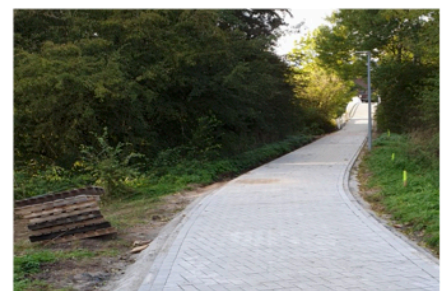
Weg von Lotsenstation zur Brücke
